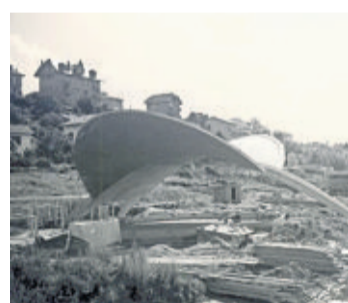
La construction de l'Orangerie en 1959, avec son plafond de 10 mètres de haut. DR
